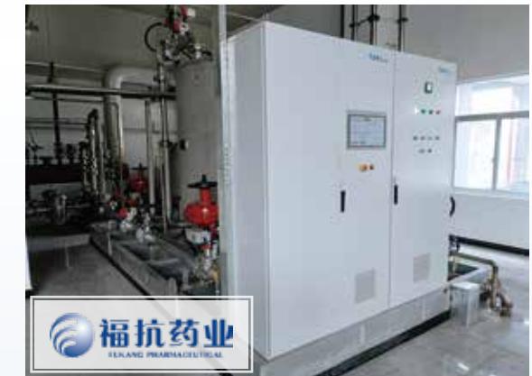
福建省福抗药业股份有限公司 Fujian Fukang Pharmaceutical Co., Ltd.
